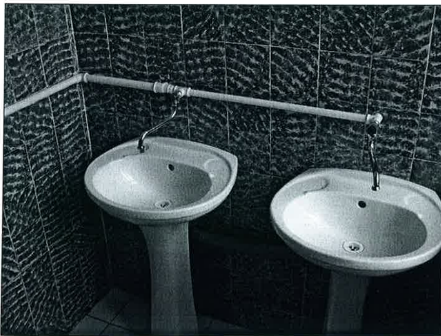
Fotografia nr 2. Umywalki wyposażone w zawory wodne wypływowe bez pokręteł
