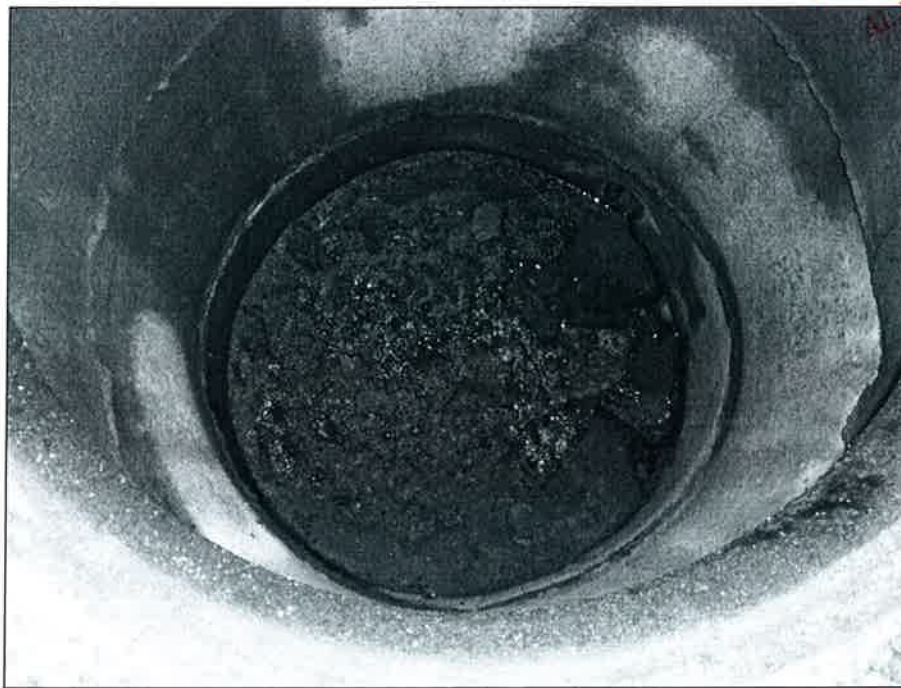
Fotografia nr 8. Zamulona studnia kanalizacji deszczowej
