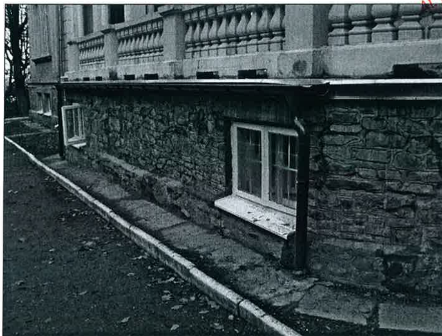
Fotografia nr 5. Odprowadzenie wód opadowych bezpośrednio do gruntu z południowego tarasu budynku
