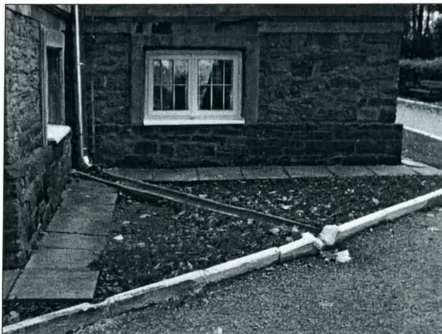
Fotografia nr 4. Odprowadzenie wód opadowych na teren w południowo – zachodniej części budynku
